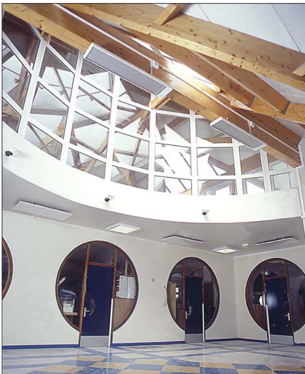
Кассеты НР обеспечивают комфорт в тех частях здания, где ниже потолки. В остальных –обогрев обеспечивается обогревателями EZF (см. стр. 28-35).
